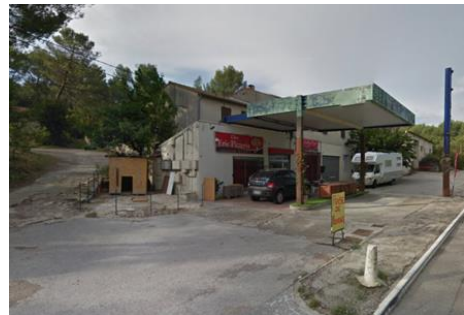
Secteur de renouvellement urbain
