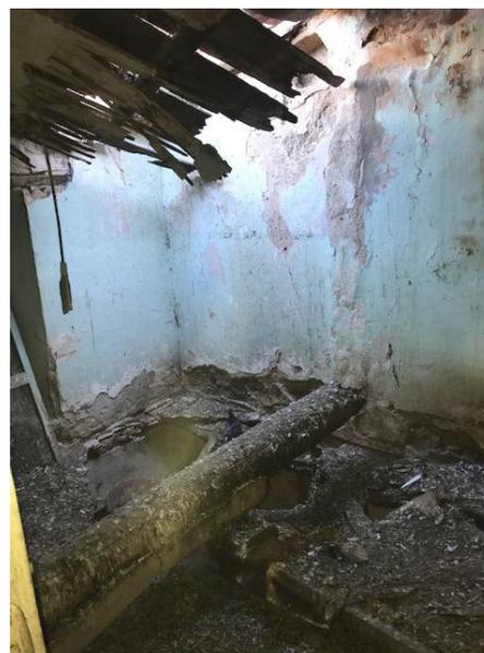
Compte tenu de son extrême vétusté, comme le montrent les photos ci-contre, ce qu'il reste de l'immeuble doit être totalement déconstruit avec l'obligation de sécuriser la tenue des murs mitoyens : toiture, planchers et partiellement façades.
